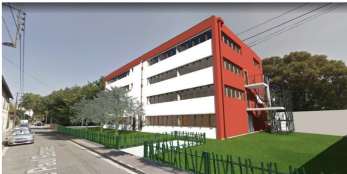
Après Paris, Nantes, Lyon ou Bordeaux, le campus HEP va débarquer à Toulouse en septembre prochain. (©HEP Toulouse)
